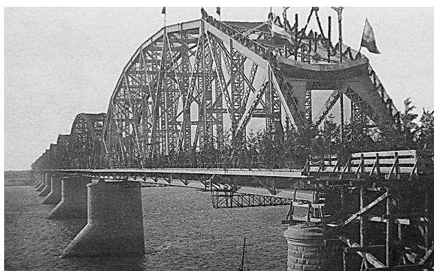
Рис. 10. Самый большой в Евразии ж.д. мост через р. Амур в день открытия движения поездов 5 (18) октября 1916 г. (фото сайта ОАО «РЖД» Дальневосточная железная дорога)
